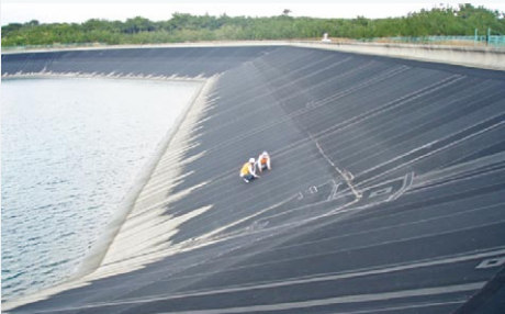
写真2 ゴムシートの目視点検の様子
