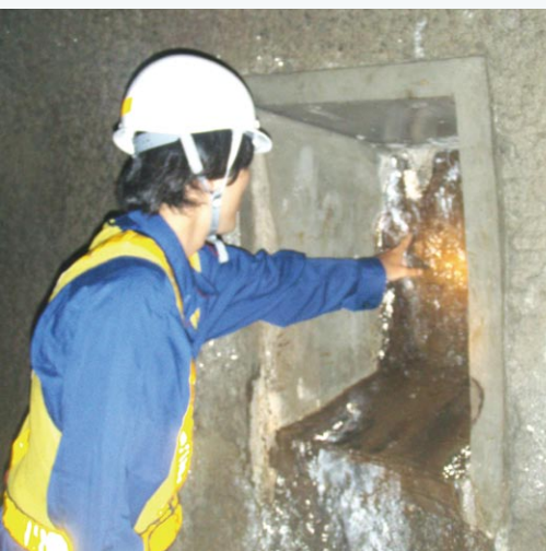
写真1 直接岩盤に触れている
