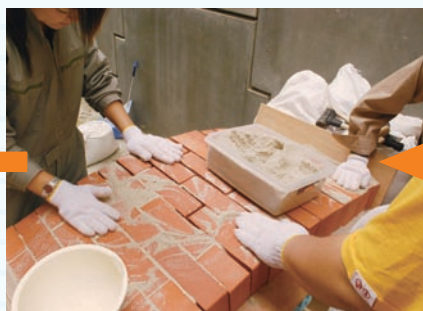
写真2 砂による隙間の除去
