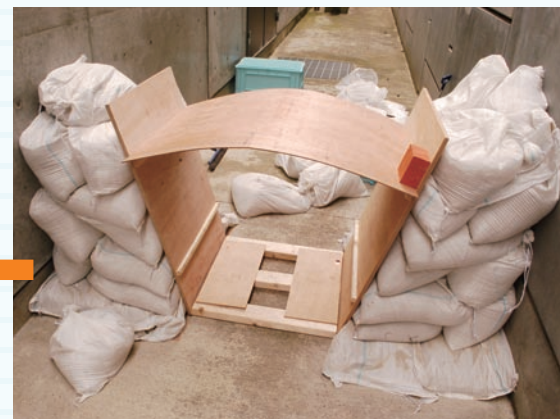
写真1 設置した支保工
