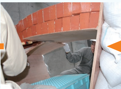
写真3 支保工の取り外し
