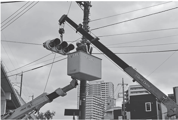
写真1 信号機の取り替え作業 (取り替え前)
