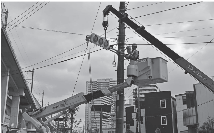
写真2 信号機の取り替え作業(取り替え後)
