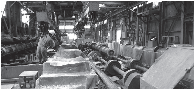
写真2 高速回転による遠心力締固めの様子
