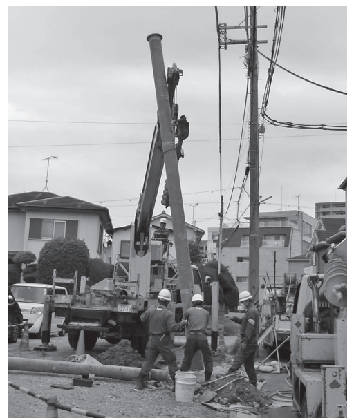
写真3 「穴掘建柱車」を使った電柱の敷設作業
