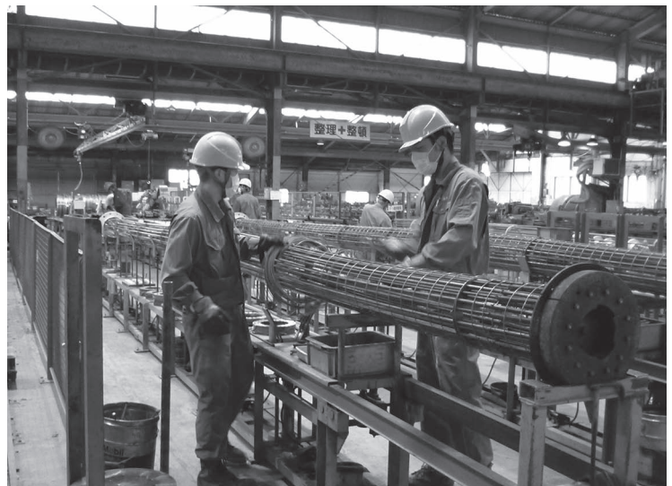
写真1 鉄筋の組み立て
