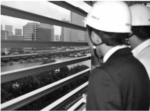
写真2 東品川棧橋部・鮫洲埋立部の現場見学写真
