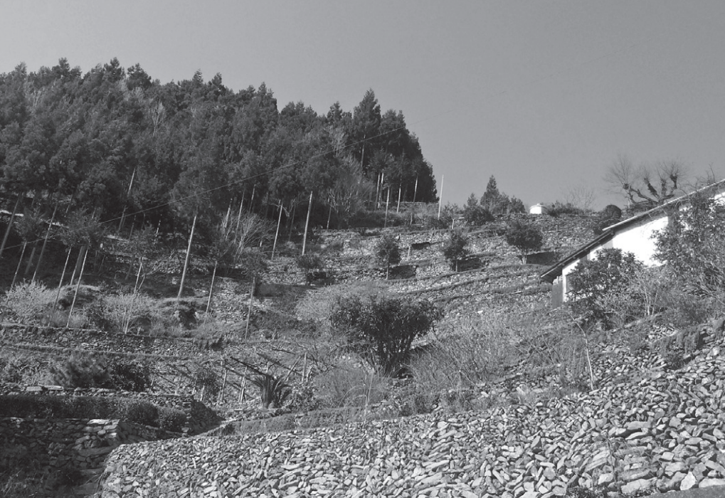
写真1 高開集落石積みの全景。古くは江戸時代から残るものもあり、急斜面に石積みを行うことは地すべりの防止にもつながる
