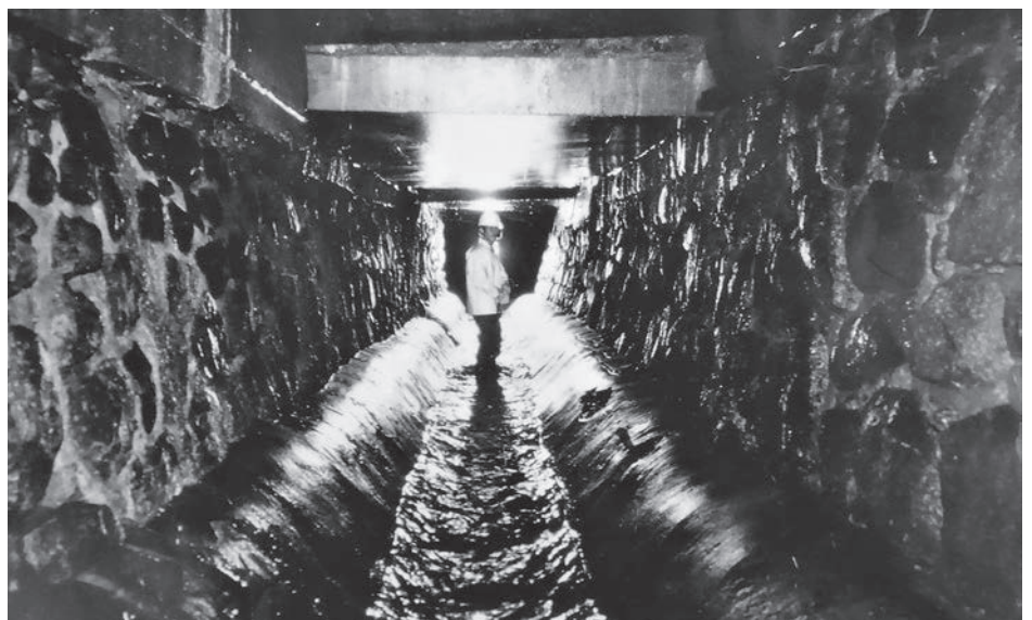
写真1 石積みの地下構造物（出典：「大阪の下水道No.26 太閤（背割）下水」）
