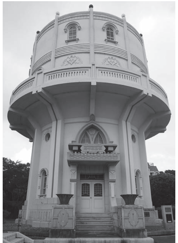
写真1 水戸市水道低区配水塔
