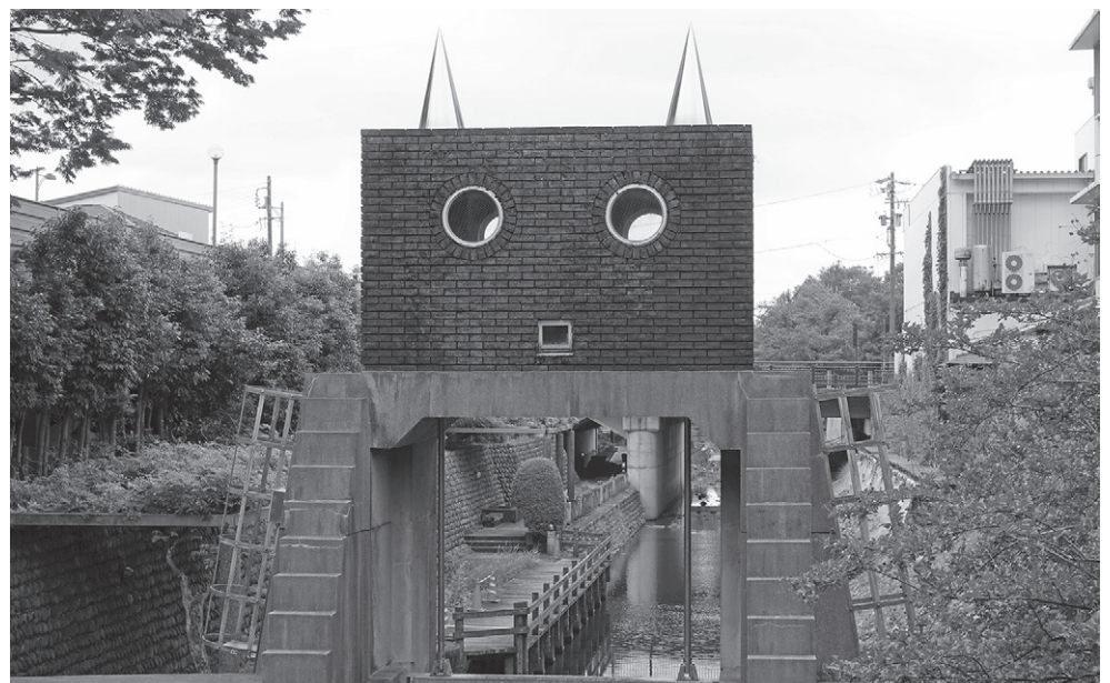
写真1 ロボット水門
