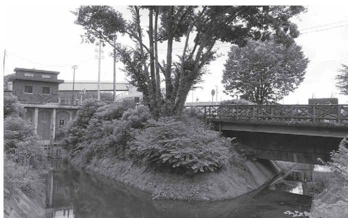
写真2 ロボット水門周辺の分岐点
