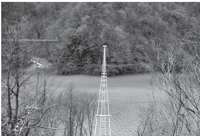
写真1 うなづき湖の吊り橋
