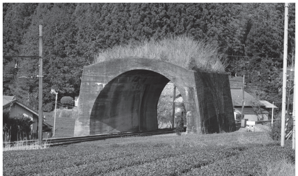
写真1 通称「日本一短いトンネル」
