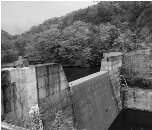
写真1 南川第一号堰堤
