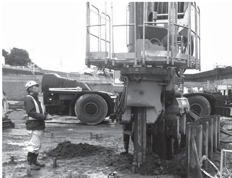
写真1 手元の操作盤を握り鋼矢板を施工する横山氏
