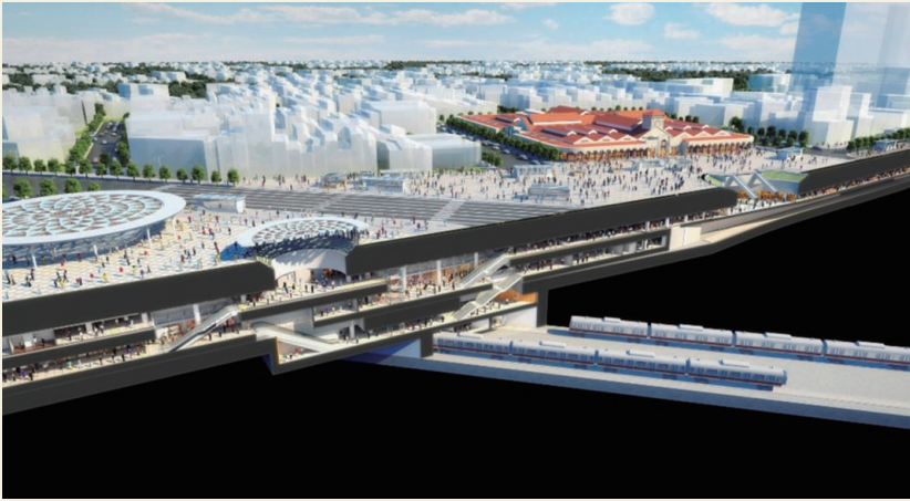
図1 土木・建築が協働して挑んだ地下空間。ベトナム初の地下鉄駅・ホーチミン「ベントイン駅」の設計（⇒34頁）
