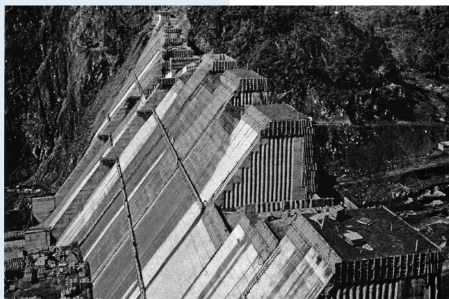
写真1 柱状工法によるコンクリートダム施工（糠平ダム、1956年竣工）（提供：（株）大林組）
