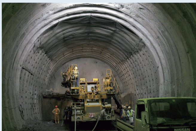
写真4 NATM工法による山岳トンネル施工（飯山トンネル、2007年完成）（提供：（株）大林組）
