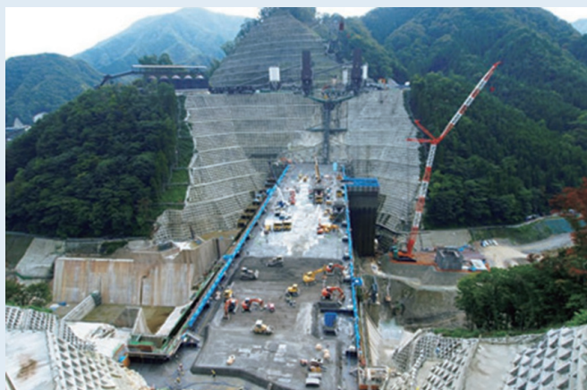
写真2 面状工法によるコンクリートダム施工（湯西川ダム、2012年竣工）（提供：鹿島建設（株））
