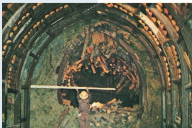
写真3 在来工法による山岳トンネル施工（中山トンネル、1982年完成）（提供：（株）熊谷組）
