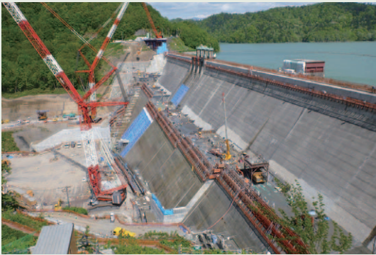
写真2 再開発中の新桂沢ダム
