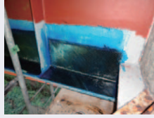
CFRPを用いた 鋼構造物の補修・補強
