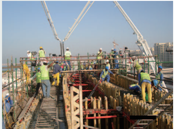
写真2 ドバイ市内の建設現場で働くインド人エンジニアとブラジル人作業員 (写真提供：(株)大林組)
