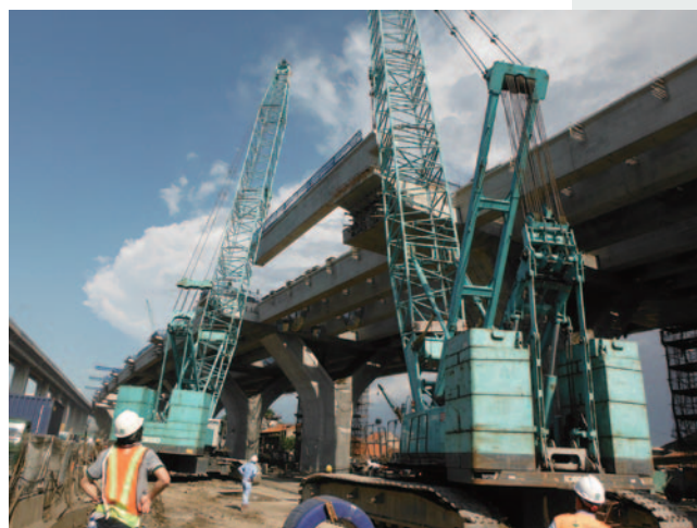
写真1 ジャカルタ市内の都市高速道路高架橋建設現場（写真提供：(株)大林組）
