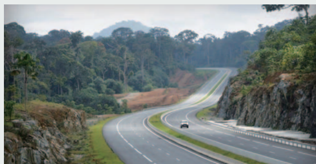
写真3 赤道ギニアでの道路整備事業 (写真提供：VINCI Construction International Network (仏))
