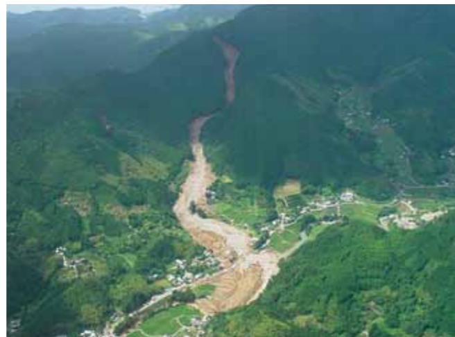
2003年熊本県宝川内集地区で発生した深層崩壊と土石流 (撮影：国土交通省九州地方整備局)
