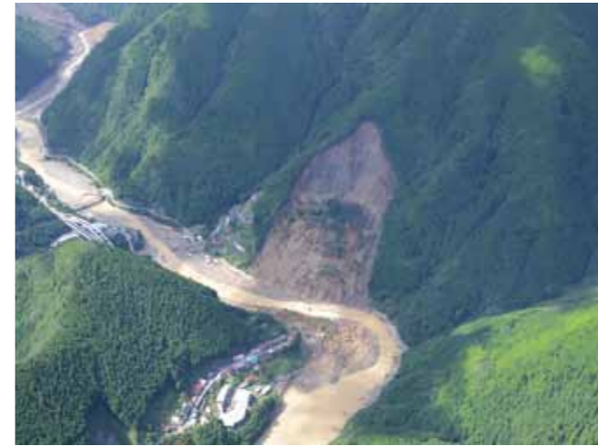
2011年奈良県五條市宇井で発生した深層崩壊 (国際航業(株)と(株)パスコとの共同撮影)
