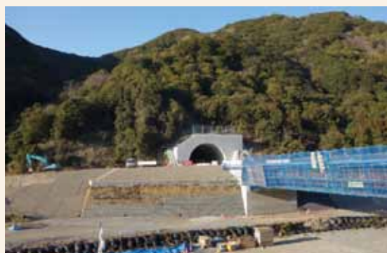
写真1 近畿自動車道紀勢線見草トンネルの抗口付近 (提供：(株)大林組)
