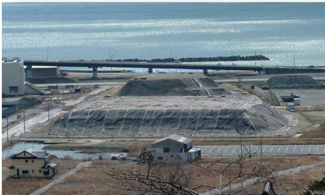
写真1 資材化され保管されている津波堆積土砂(宮城県石巻市)(撮影:久田 真)
