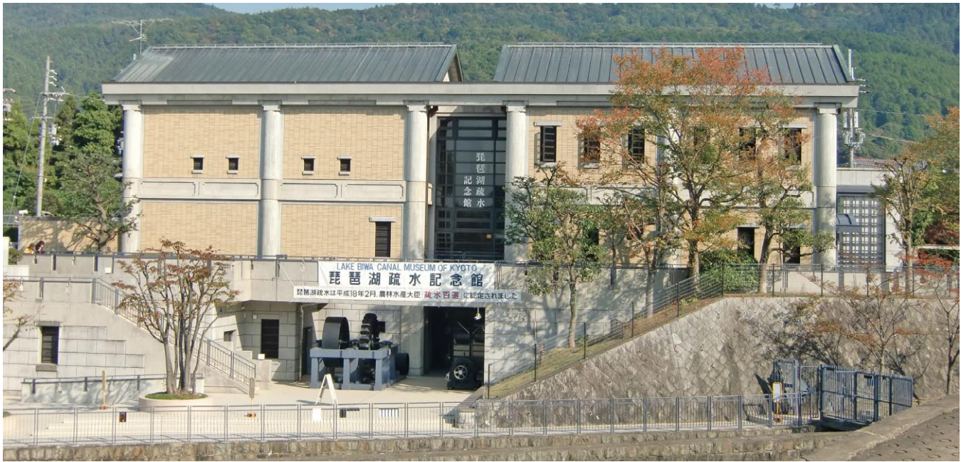
文化施設が多い落ち着いたまちの一角にある琵琶湖疏水記念館
