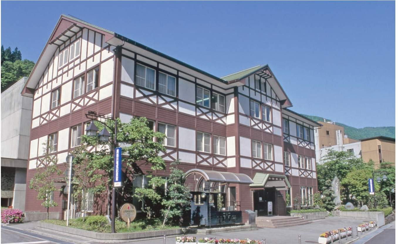
黒部川電気記念館外観(提供：関西電力(株))
