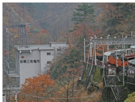
黒部峡谷鉄道と新黒部川第三発電所
