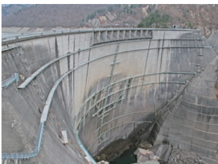
圧倒的なスケールの黒部ダム(クロヨン)
