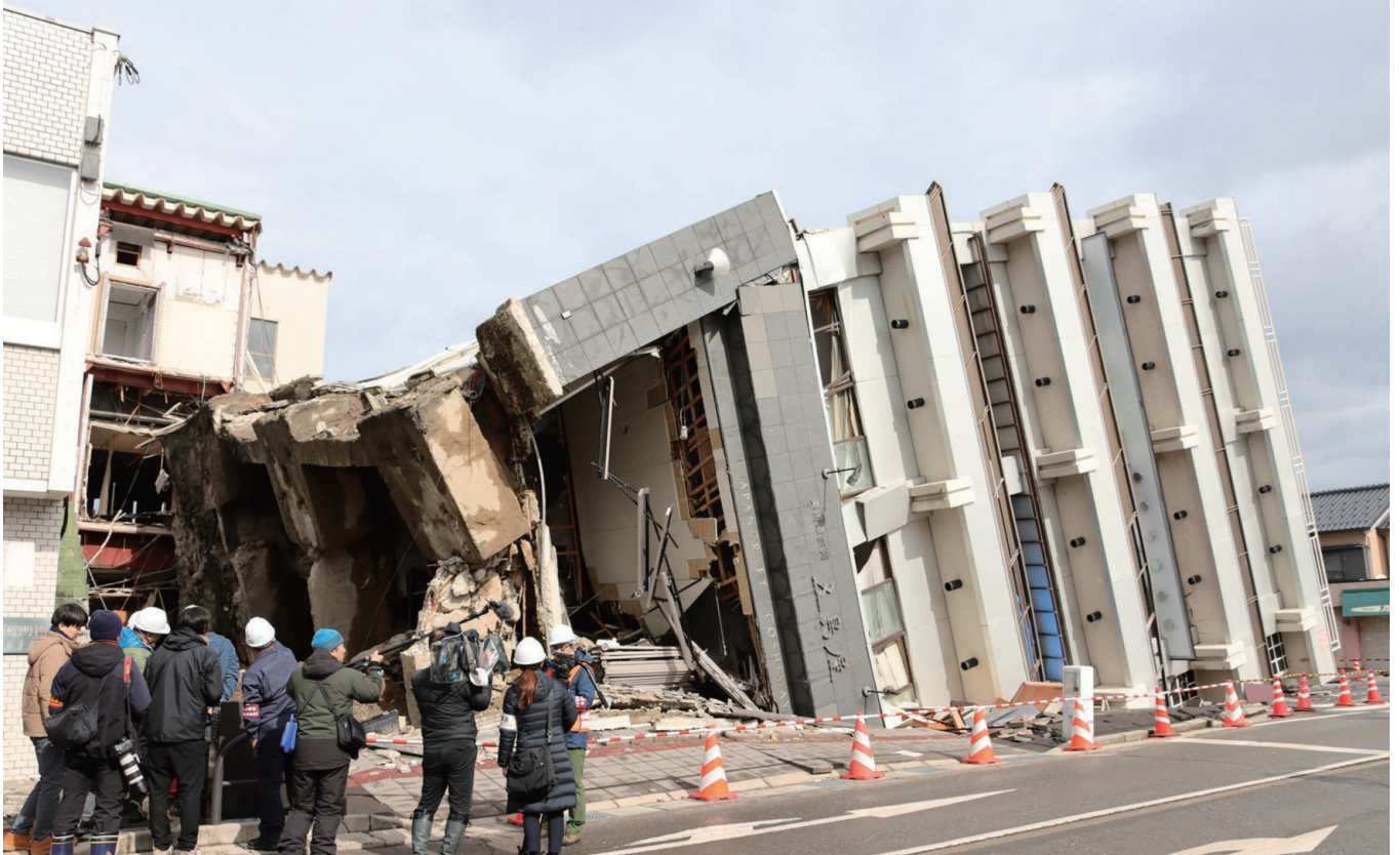
写真4 輪島市河井町 被災市街地（上：広域火災の現場、下：ビル倒壊の状況）
