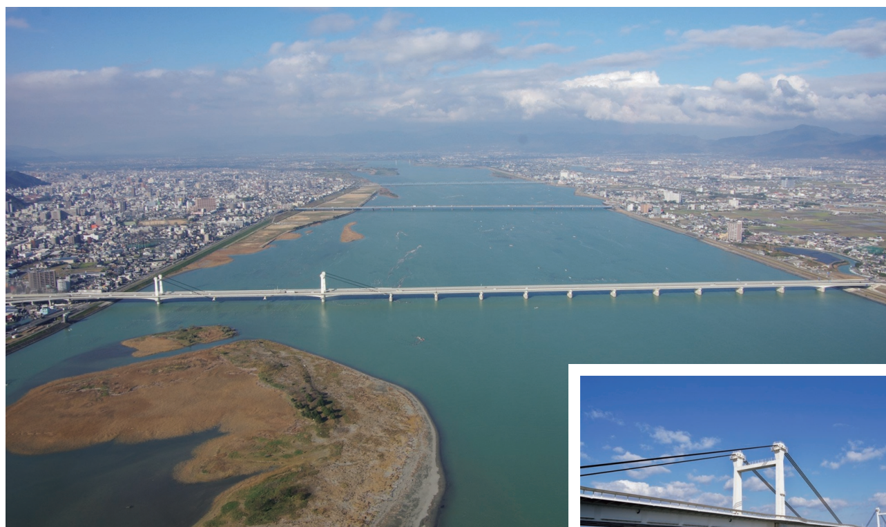
写真3 吉野川河口から上流を望む（一番手前の橋が「阿波しらさぎ大橋」）（左下の干潟部の上にあたる部分を吊橋（ケーブルリグレット工法：右下にアップ写真）とし長大スパンにすることで橋脚の数を減らしている。）
