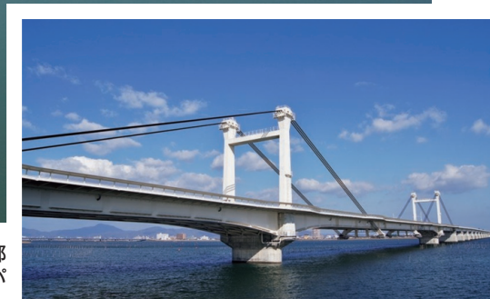
写真3 吉野川河口から上流を望む（一番手前の橋が「阿波しらさぎ大橋」）（左下の干潟部の上にあたる部分を吊橋（ケーブルリグレット工法：右下にアップ写真）とし長大スパンにすることで橋脚の数を減らしている。）
