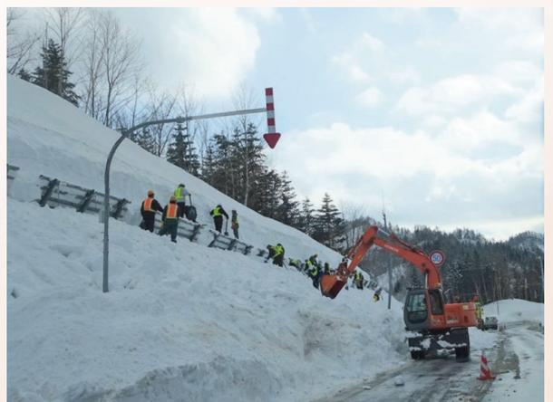
写真2 北海道内での道路除雪・雪崩防止作業
