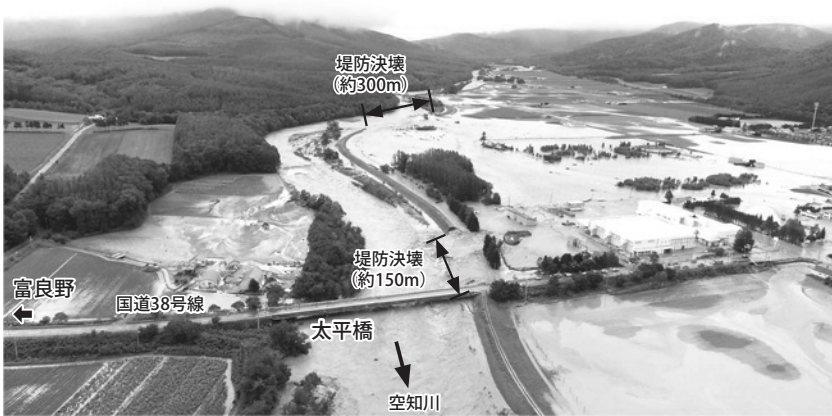
図1 北海道南富良野町での空知川の堤防決壊と氾濫の状況 (2)
