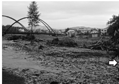
河岸浸食による家屋の被災 (清水町・ベケレベツ川 2016/9/6)
