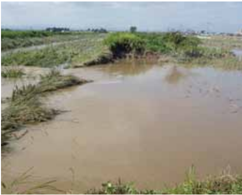
写真1 破堤箇所の様子 (渋井川) (提供: 呉修一)
