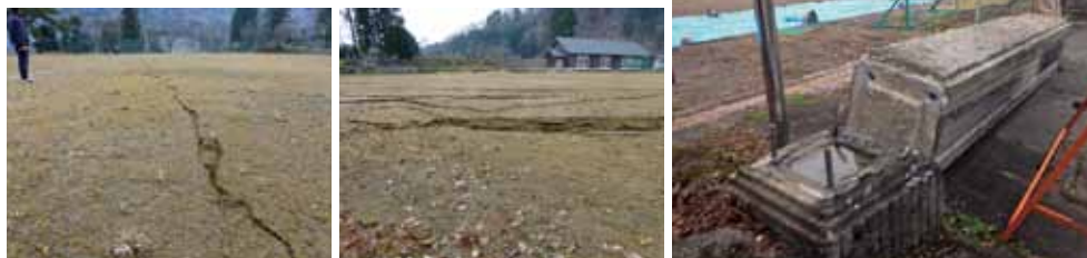
写真11 長野市鬼無里中学校 校庭の亀裂 (提供：長野市教育委員会)、門柱の転倒→図1⑪
