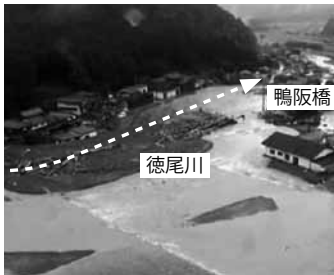
図3 徳尾川における土砂崩壊と河道閉塞(兵庫県防災ヘリ映像より)
