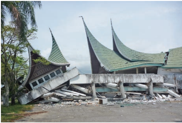
写真1 建築物の被害
