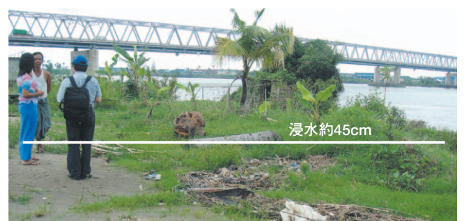
写真5 ヤンゴン川支流(河口より64km)での浸水
