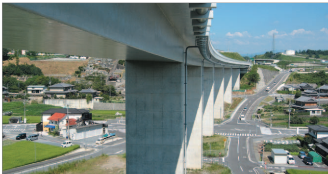
写真2 垂井高架橋の全景
