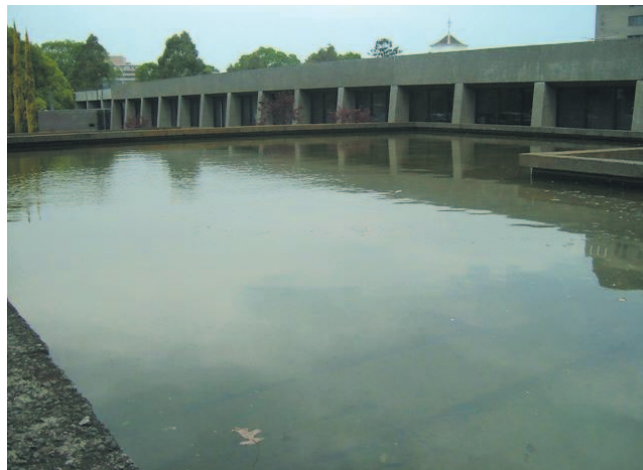
写真-6 雨水を屋上のプールに貯める
