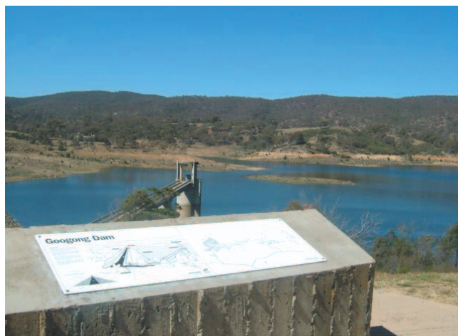
写真-4 ゲーゴン・ダム
