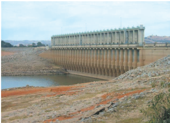
写真-1 水位の低下したシドニーのワラガンバ・ダム
