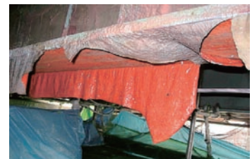
インバイロワン塗布後24時間 塗膜が軟化して剥がれる様子
