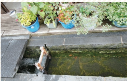
写真2 家先を流れる用水路 家族名のついた堰板で水をせき止める
