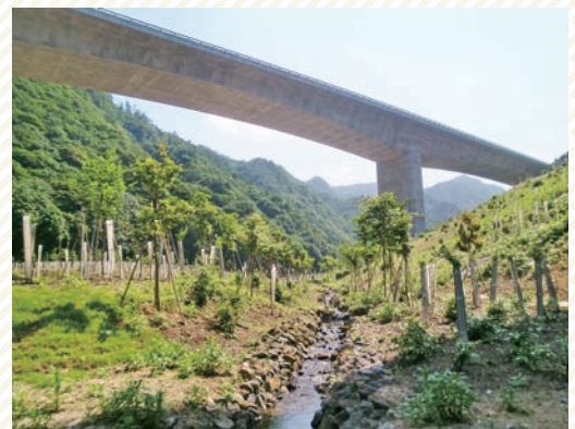
写真2 地域性苗木やトンネルズリで復元された鈴鹿トンネル東坑口付近
