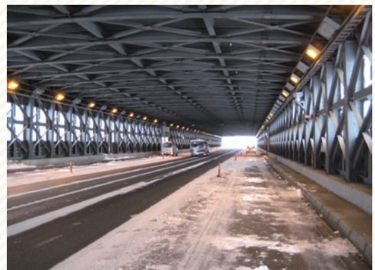
写真2 シエルター内部の状況：中央部は走行帯、両端部は駐車帯
