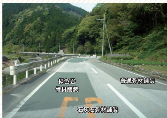
写真2 補修工事によるカラフルな3色舗装
