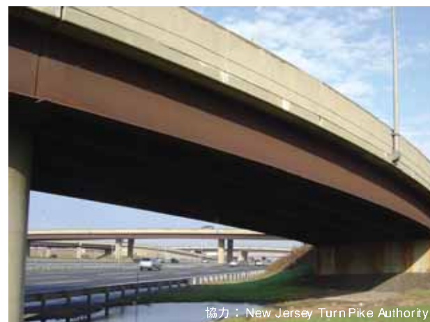
インターチェンジの風景 (New Jersey Turnpike)
