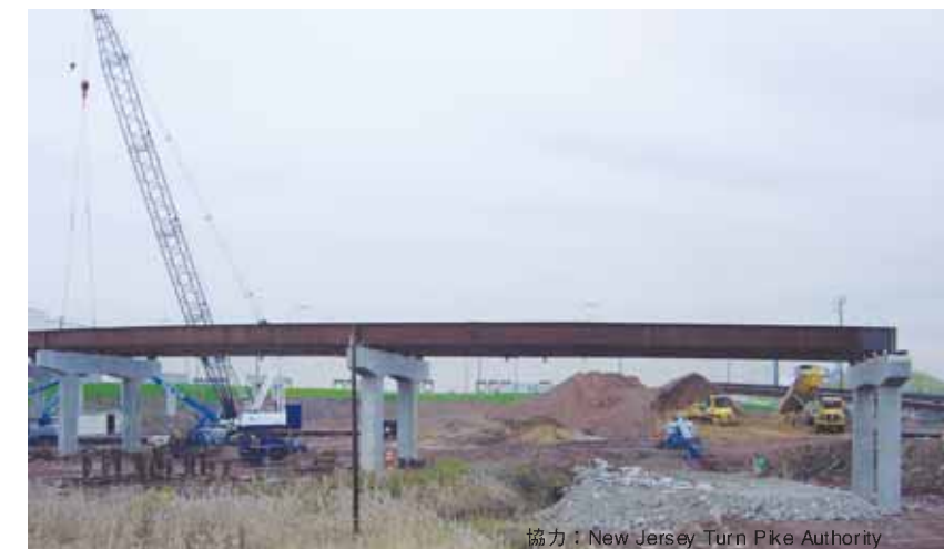
架設時間の短縮は鋼橋の大きなメリット (New Jersey Turn Pike)
