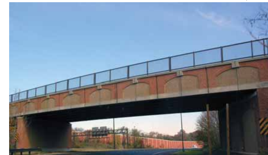
耐候性鋼橋梁の外桁外面にレンガ模様の化粧板を取り付け景観性向上 (Annapolis, MD)
