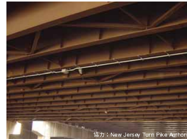
12車線を支える42本主桁のマルチガーター橋
