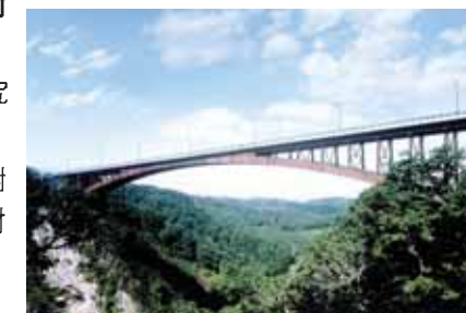
緑に映える耐候性鋼橋梁
