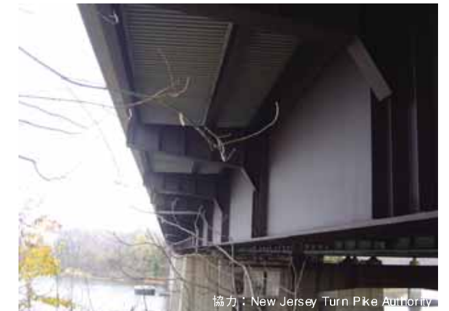
既存塗装橋の拡幅部(外桁)に耐候性鋼が用いられた例
