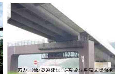
北陸新幹線・北陸架道橋 ニッケル系高耐候性鋼橋梁(さび安定化補助処理)
