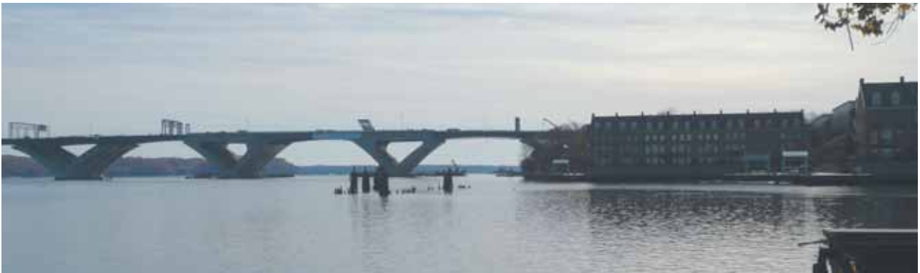
建設中のHPSを使用するビッグプロジェクト—ウッドロウウィルソン橋 (幅員78m、12車線)
