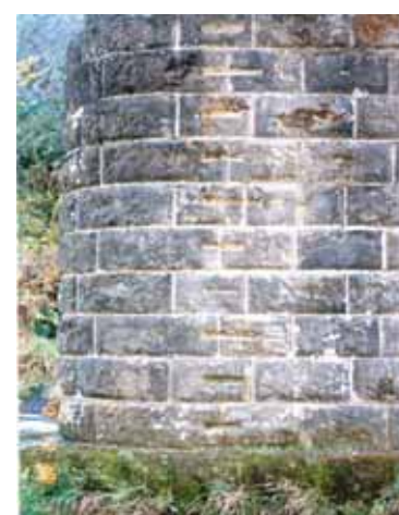
橋脚に刻まれた切れ込み
