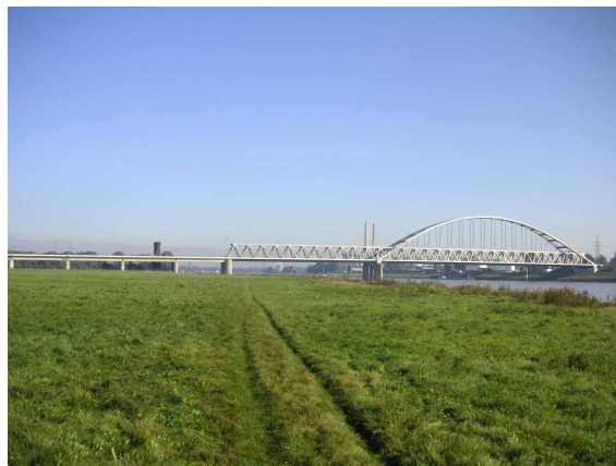
写真-3 上流側からの眺め
