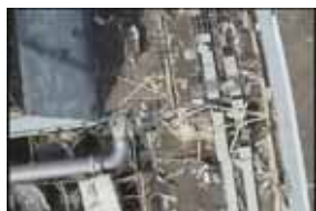
1号機南東角建屋カバー柱
