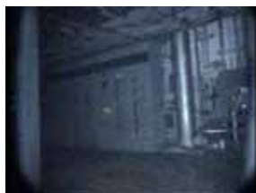
2号機原子炉建屋1階
