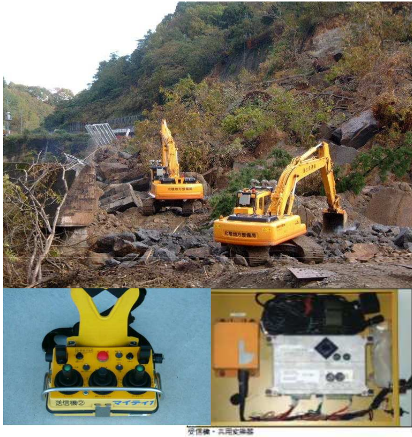
新潟県中越地震長岡市妙見での人命救助支援 (平成16年11月)
