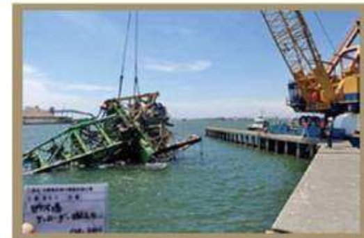
アンローダー揚収状況
