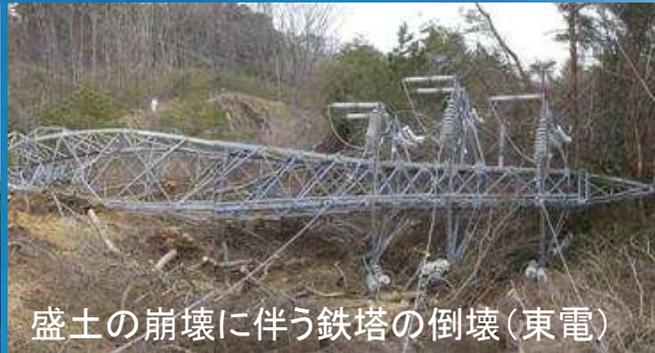
盛土の崩壊に伴う鉄塔の倒壊(東電)
