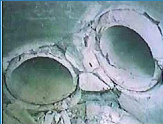
マンホールと管きよの接合部破損
