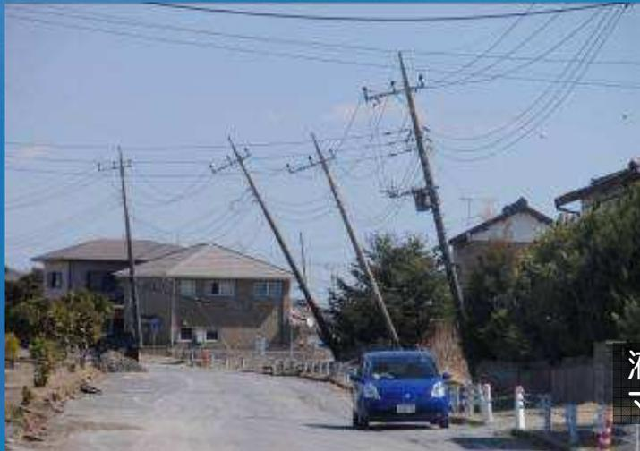
液状化に伴う電柱の傾斜
