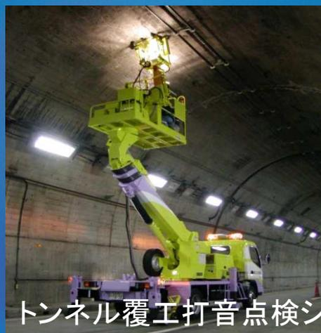
トンネル覆工打音点検システム
