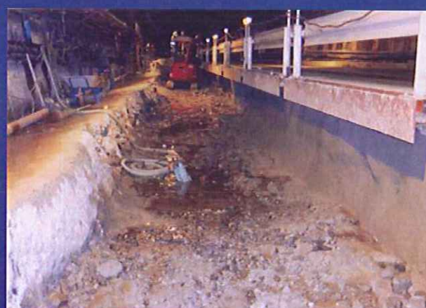
片側交通規制しながらの インバート掘削状況
