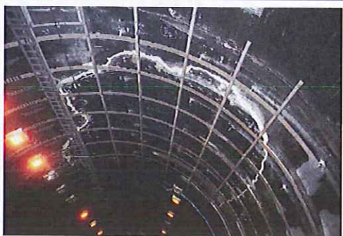
形鋼系当て板工
