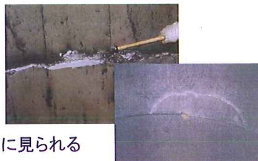
矢板工法に見られるひび割れ・漏水
