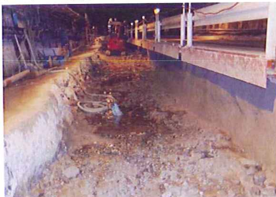
図－4 インバートによる補強の施工例
