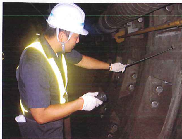
シールドトンネル側部の打音調査
