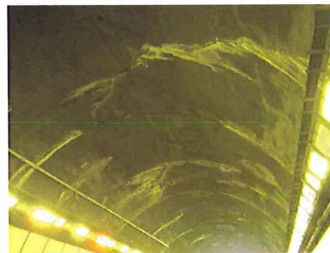
矢板工法に見られるひび割れ・漏水
