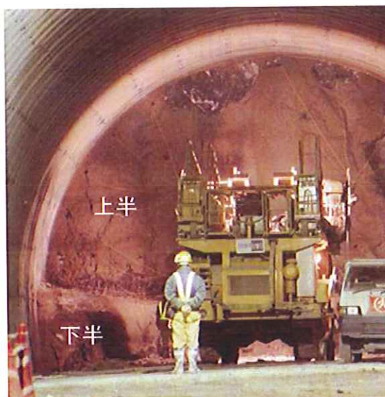
補助ベンチ付き全断面での掘削
