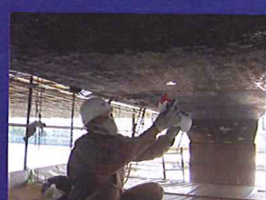
中性化試験状況
