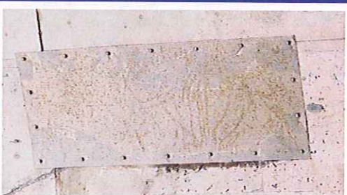
パネル系当て板工
