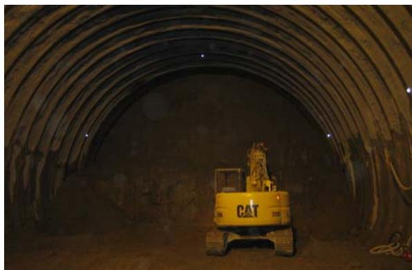
図-3 補助ベンチ付き全断面工法の例
