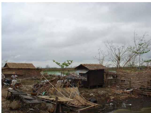
集落 （バゴー川右岸・河口から 21km） （証言）道路上 15cm 程度まで冠水。
