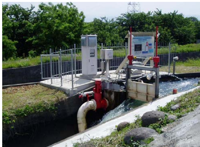
図 6-1 水路の落差を利用した発電の実証試験状況（出典：経済産業省、小水力資源有効活用平成 16 年度報告書）
